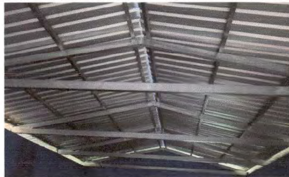
Foto 2: Sustitución de estructura de soporte de madera por metal de todo el establecimiento educativo.
