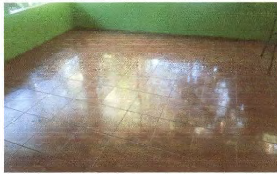
Foto 4: Sustitución de piso de cemento liquido por piso ceramico en aulas, corredor y baños de todo el establecimiento educativo.
