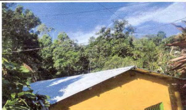
Foto1: Sustitución de lamina, capote, elementos de fijación de todo el establecimiento educativo.
