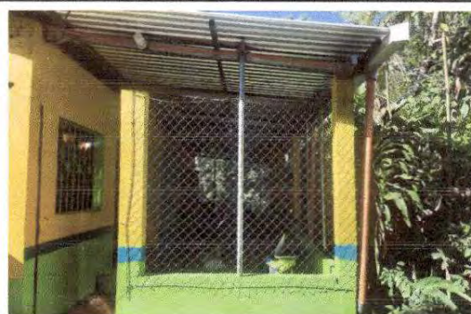
Foto 10: Reparación de tubo hg y malla galvanizada de todo el establecimiento educativo.
