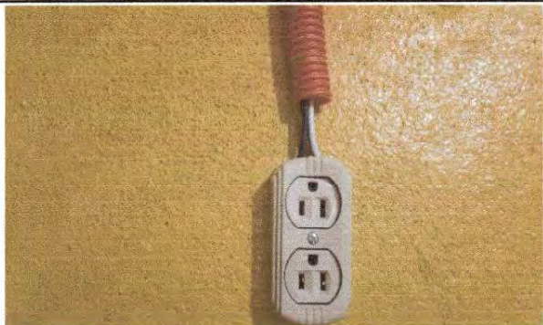
Foto13: Sustitución de tomacorrientes dobles de todo el establecimiento educativo.
