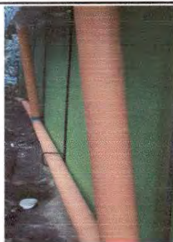
Foto 5: Sustitución de canal de pvc, pescantes, bajadas de agua pluvial de todo el establecimiento educativo.
